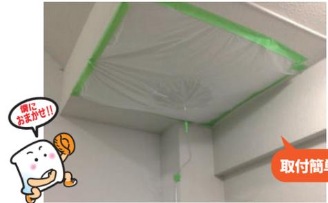
突然発生する水漏れは場所を選んでくれません。そんな時はポタポタキャッチが有効です。水漏れ箇所に合わせて専用テープで貼り付け、専用ホースを取り付けることでご希望の場所に水を送ることができます。
